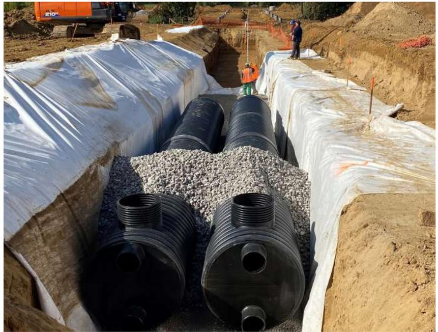
Bassin de tamponnement / infiltrant réalisé Par Polieco avec un tube SN8, ID 1200 mm.
