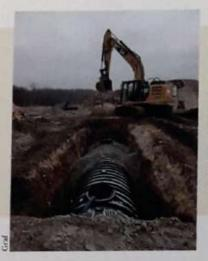
Cette cuve Carat XXI (42 000 I) de Graf bénéficie d'un dôme pivotant à 360° qui facilite son raccordement. Elle peut être équipée d'un filtre intégré qui garantit la qualité de l'eau récupérée. Les rehausses télescopiques s'ajustent au millimètre près avec la surface du terrain.
