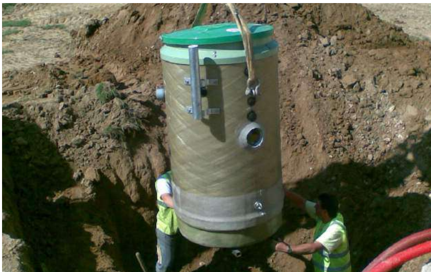
Les postes de relevage Varylift de Simop sont équipés de pompes à roue vortex et d'un corps de refoulement en fonte, avec interrupteur à flotteur intégré.
