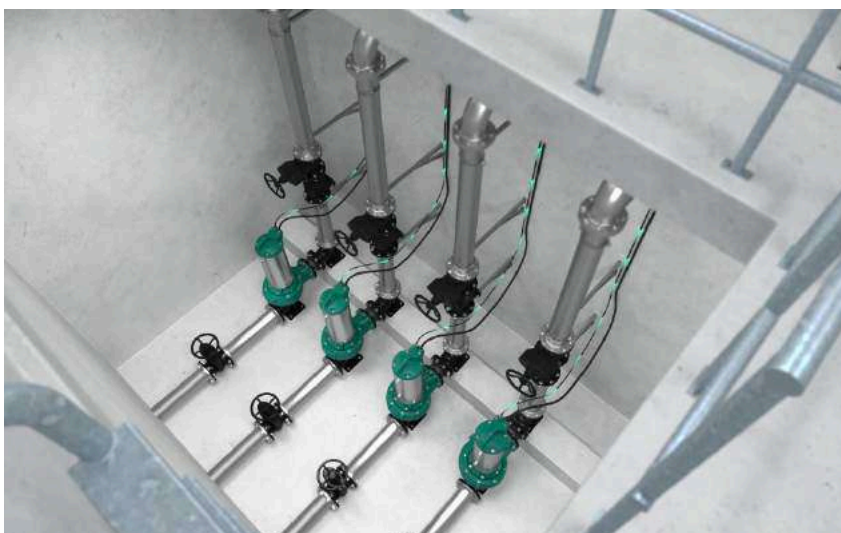
Grâce à ses propriétés autonettoyantes, la pompe Solid Q de Wilo participe à la réduction des coûts d'entretien des postes de pompage.
