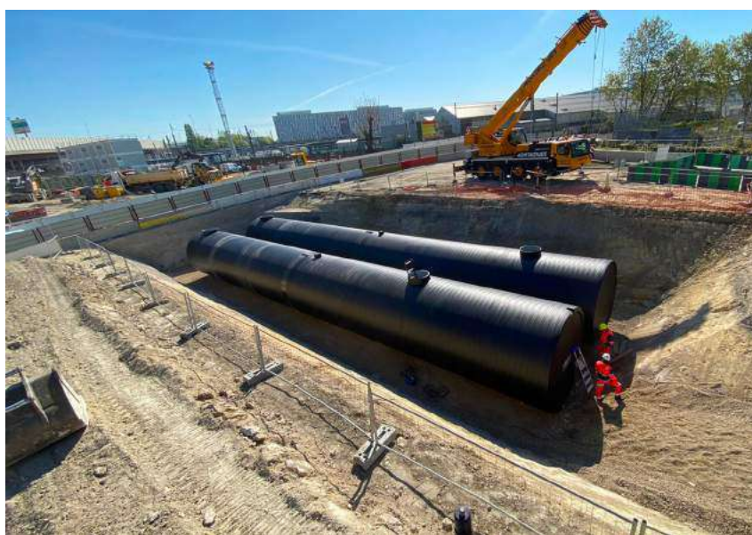
Tubao propose des solutions de grand format comme cet ensemble de deux lignes de rétention de 27 m en PEHD, capables de retenir jusqu'à 260 m 3 d'eau et disposant d'un volume mort de 80 m 3 pour le piégeage des MES.
