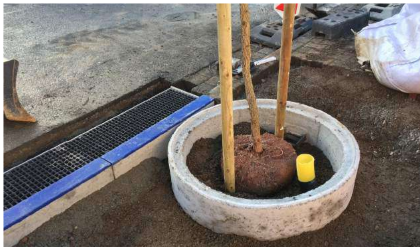
MEA France propose son substrat filtrant MEACLEAN PRO, qui s'installe en fond de caniveau. L'eau purifiée peut irriguer le racinaire des arbres urbains.
