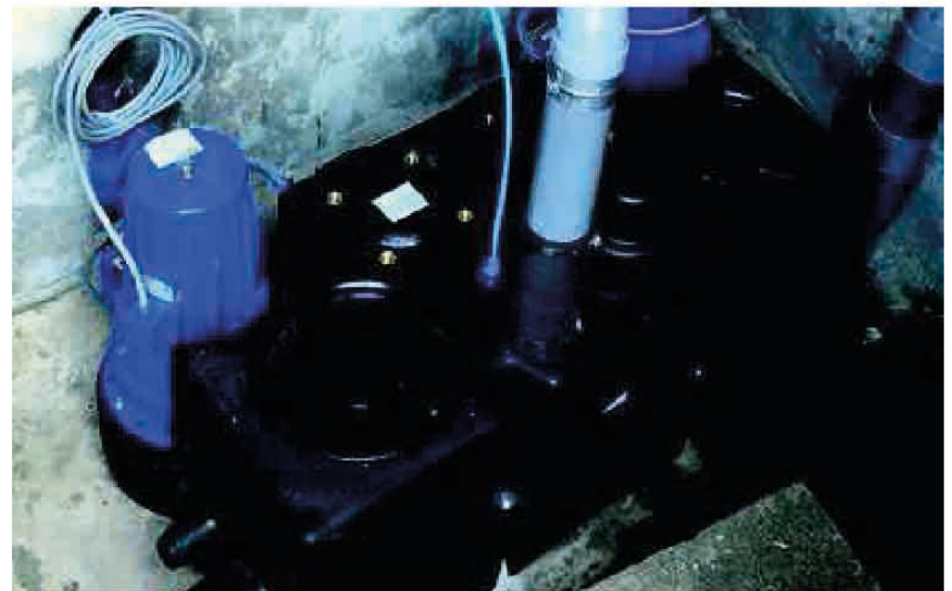
SFA a équipé un immeuble de huit appartements pour relever et raccorder l'ensemble des équipements des sanitaires au tout à l'égout. Pour ce projet, il a proposé sa solution Sanicubic 2 GR, équipée de deux pompes dilacératrices d'un débit de 17 m 3 /h pour une HMT jusqu'à 39 m.
